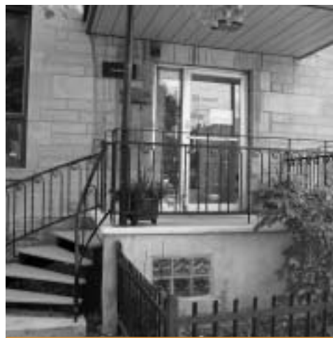
Le CASC M, 32, boulevard Saint-Joseph Ouest, (514) 842-8045.
