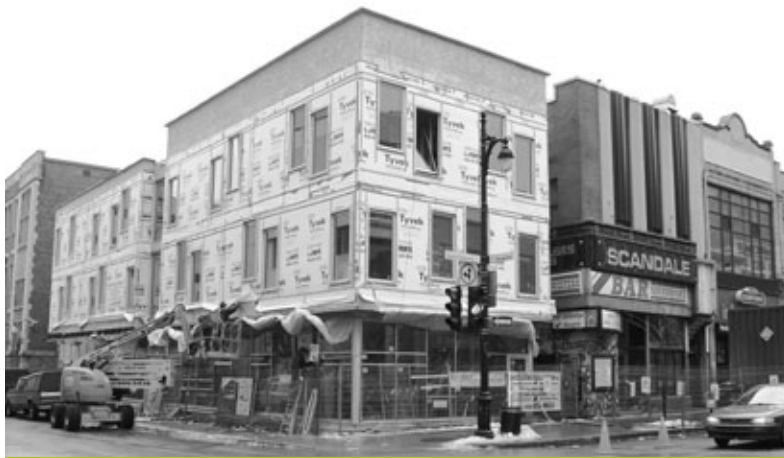
Pierre Legros a suivi de près la construction du nouvel immeuble de CACTUS Montréal. Voici où en étaient les travaux à la fin du mois de mars cette année.
